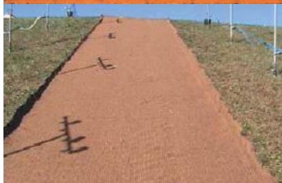
Figura 2.– Instalación en Taludes de la Manta de Control de Erosión AEC Premier Coconut™
