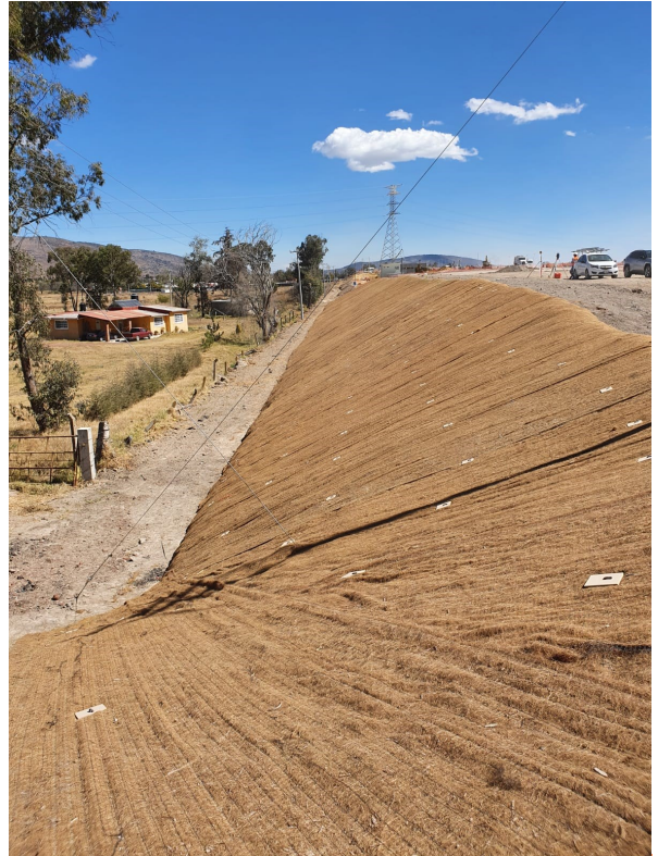
Figura 1.– Biomanta de Fibra de Coco Landlok® C2 para Control de Erosión y revegetación.
