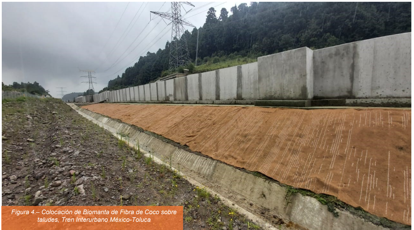
Figura 2.– Tendido de Rollos de Biomanta de Fibra de Coco sobre Talud, Tren Interurbano México-Toluca
