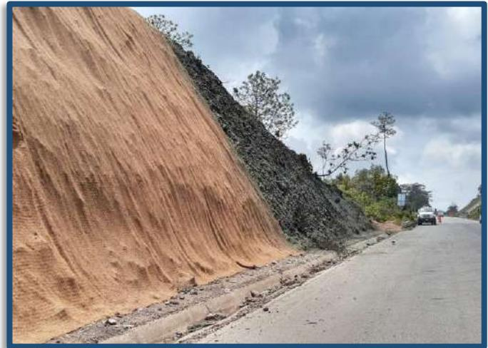
Lurrán BC320 fue diseñado para promedios de pérdida de suelo (eventos basados en el factor RUSLE C) de 0.10, normalmente adaptable a taludes 1:1. Lurrán BC320 es capaz de resistir flujos de orden de los 9.0 ft/s(2.7m/s) y 2.25 lb/ft<sup>2</sup> (108 Pa) resistencia al estrés de ruptura.
